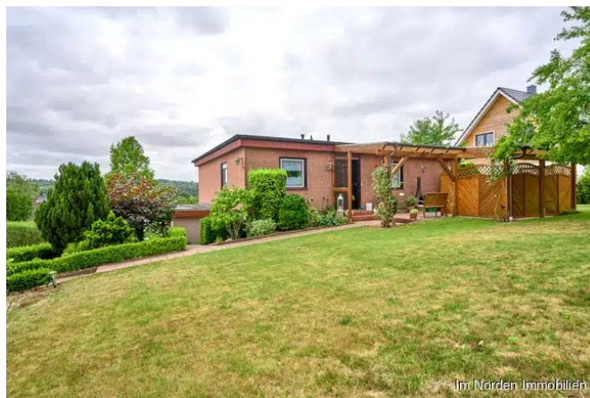
Blick von der Straße
