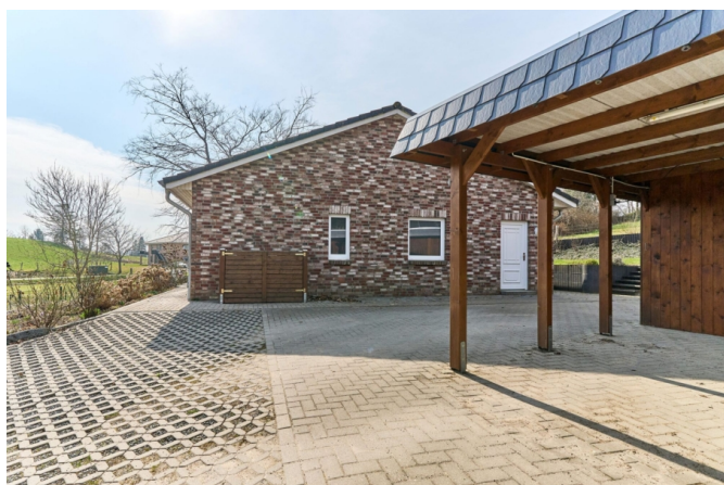
Carport, gepflasterte Hoffläche
