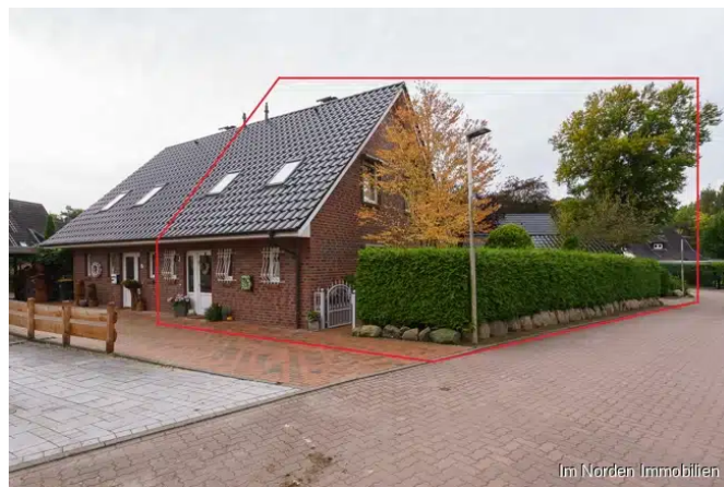
Blick auf die Haushälfte Brunnensteg Nr.2
