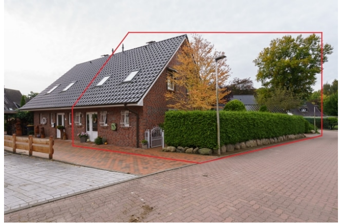
Blick auf die Haushälfte Brunnensteg Nr.2
