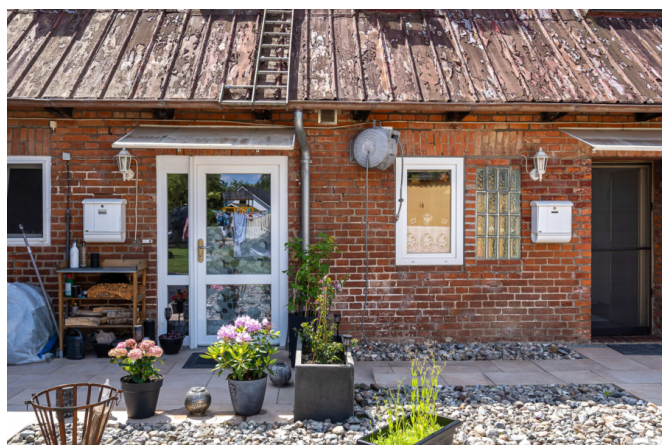
Wohneinheit Nr. 3 - Blick auf die Eingangstür
