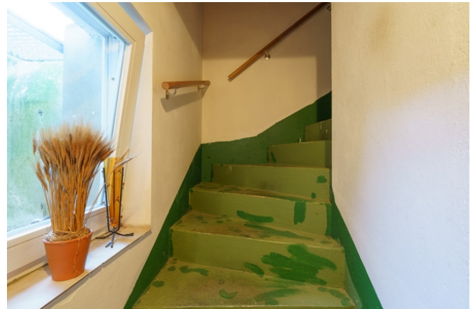
Treppe ins Kellergeschoss
