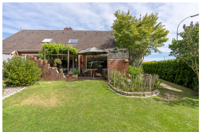
Blick vom Garten auf die Terrasse
