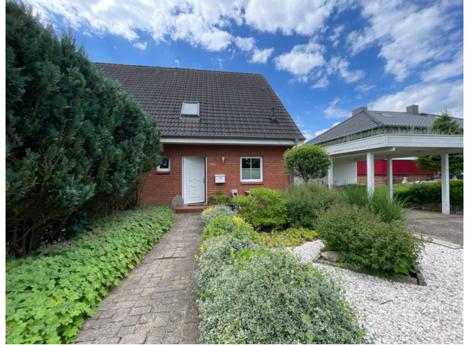
Blick auf den Hauseingang und das Carport
