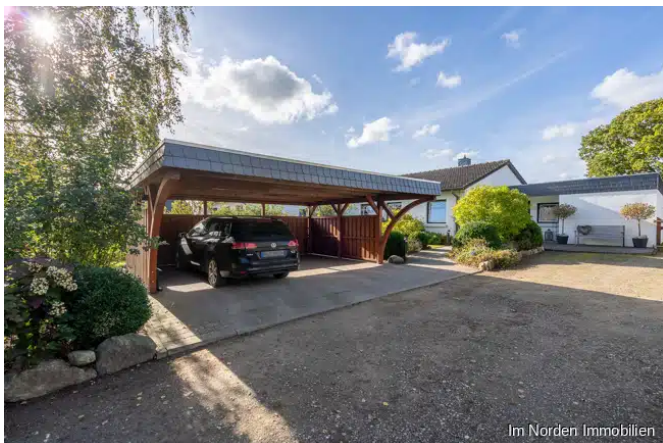
Blick auf das Carport
