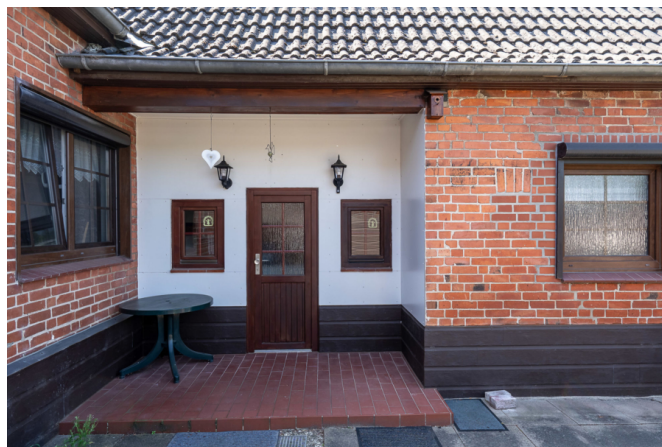
Hauseingang zur Terrasse
