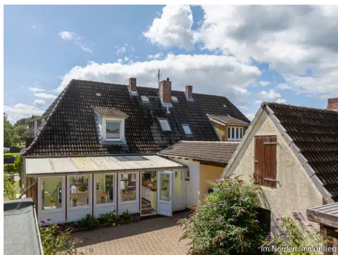
rückwärtige Ansicht, Hofplatz, Wintergarten
