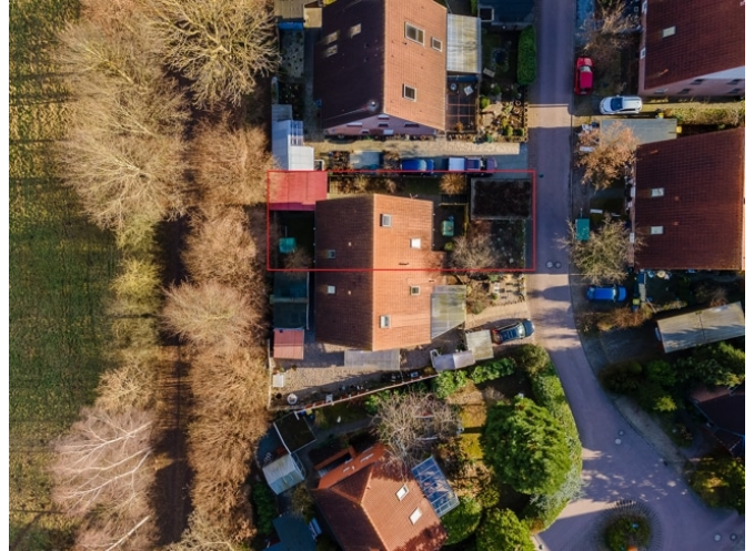
Haushälfte von oben
