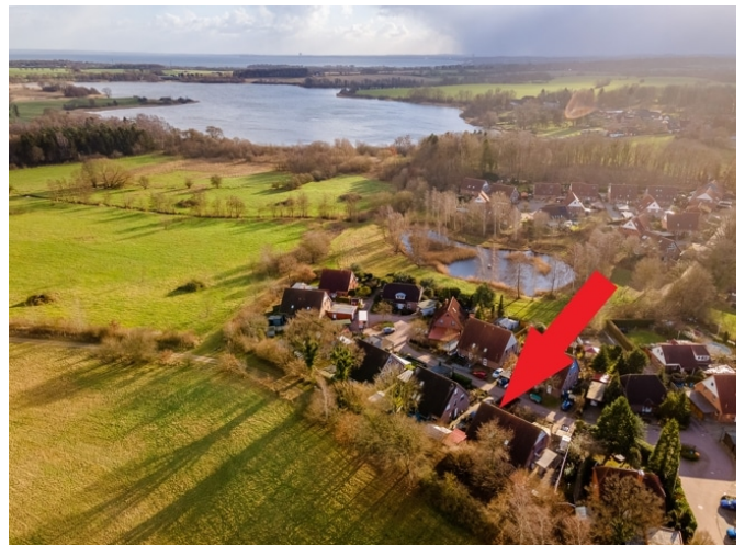
Haushälfte von oben
