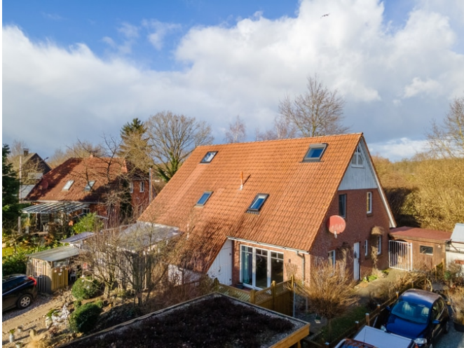
Haushälfte von oben
