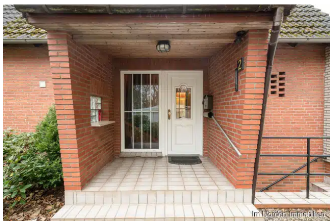
Blick auf den Hauseingang
