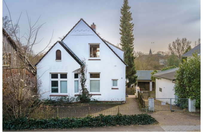
Ansicht von der Kellerseestraße
