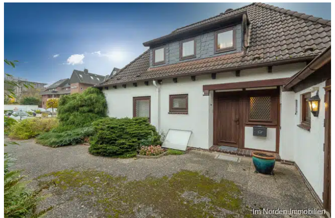
Hausansicht von der Auffahrt
