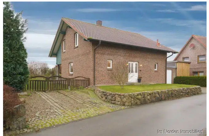
Hausansicht von der Straße
