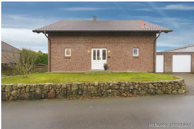
Hausansicht von der Straße
