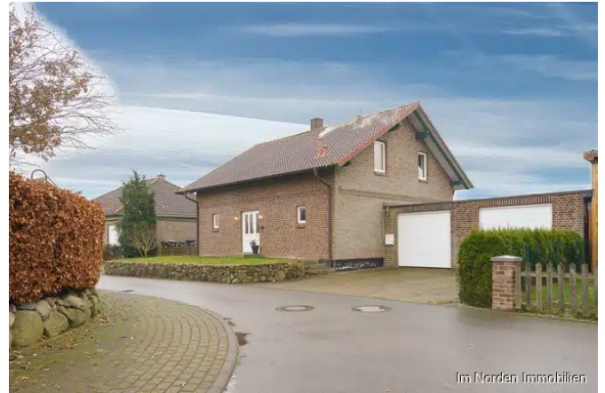
Hausansicht von der Straße
