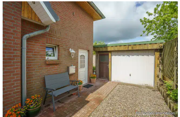
Hauseingang ins Dachgeschoss
