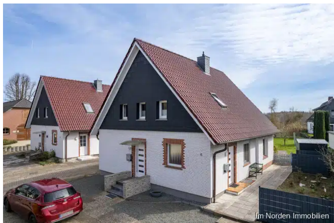
Ansicht von der Dorfstraße
