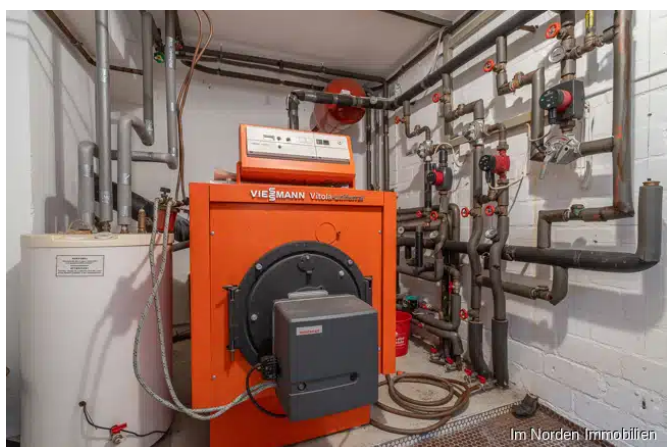
Ölheizungsanlage von 1997
