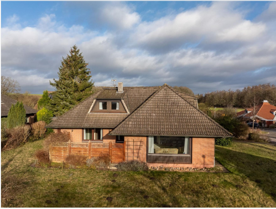
Ansicht von der Strasse
