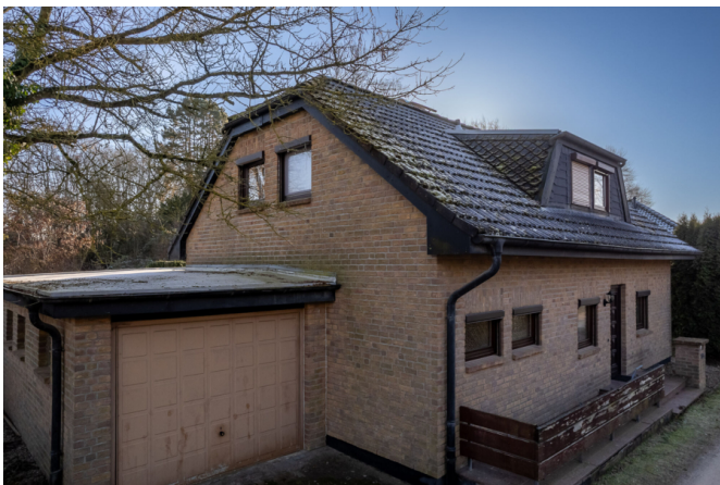
Ansicht von der Zufahrtsstraße
