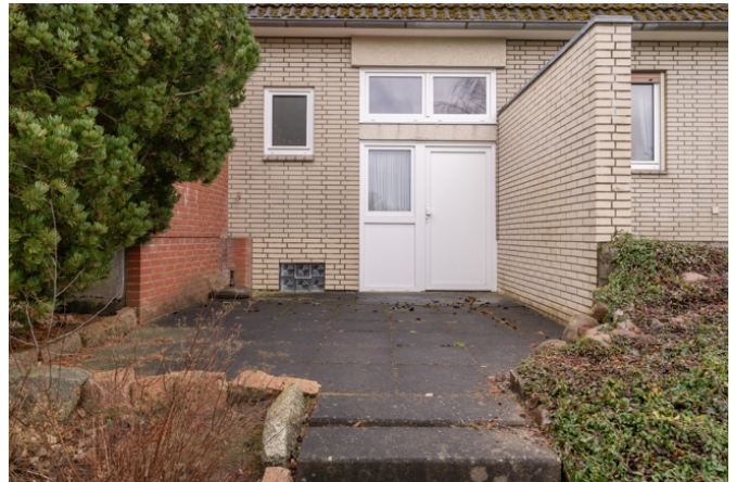
Hauseingang zum Keller
