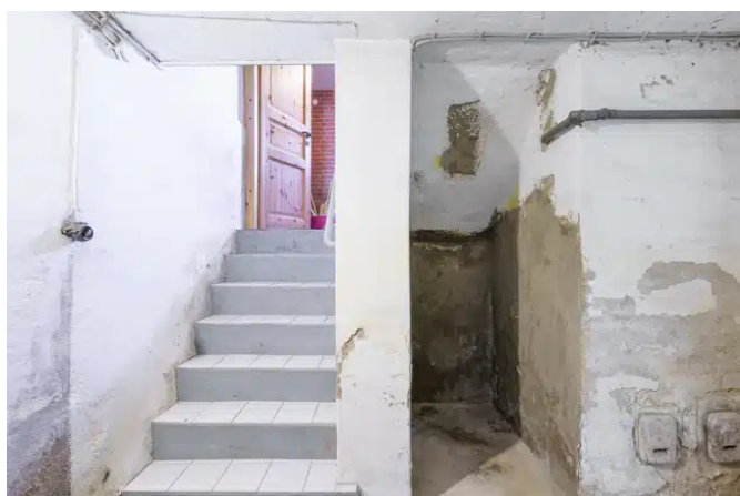
Treppe in den Keller
