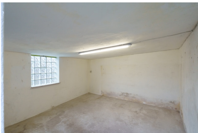
ehemaliger Werkstattraum im Anbau
