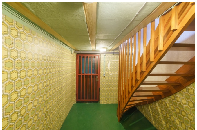
Flur im Kellergeschoss
