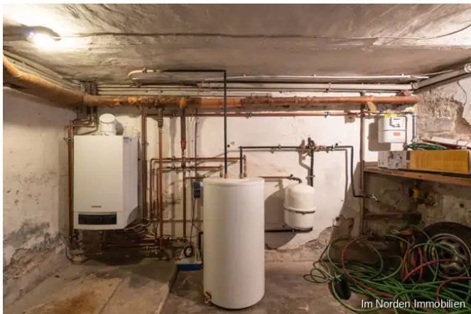
Gas-Heizungsanlage Kellergeschoss
