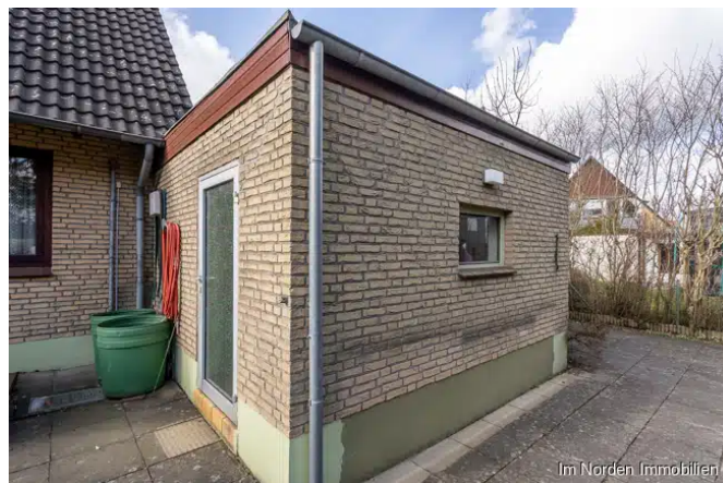
Ansicht der Garage vom Garten
