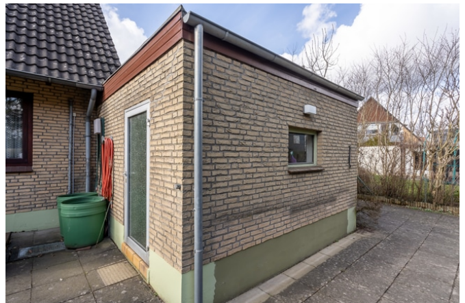
Ansicht der Garage vom Garten
