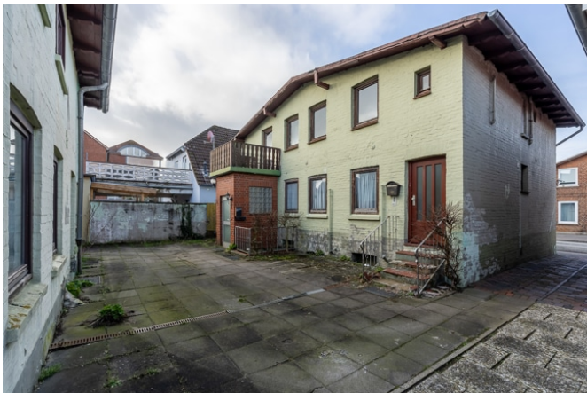
Blick auf den Hofplatz und die Zuwegung
