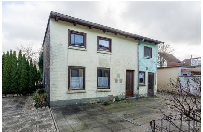
Blick auf das Hofgebäude
