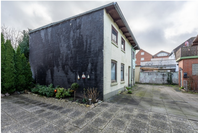
Blick auf das Hofgebäude
