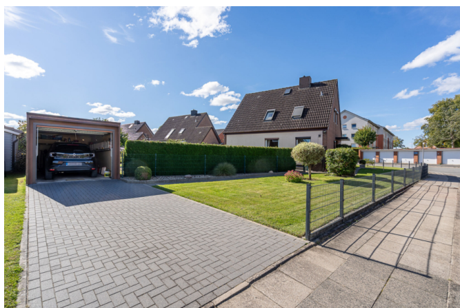
Garage mit Zufahrt
