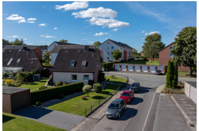
Ansicht von der Straße "Dornrade"
