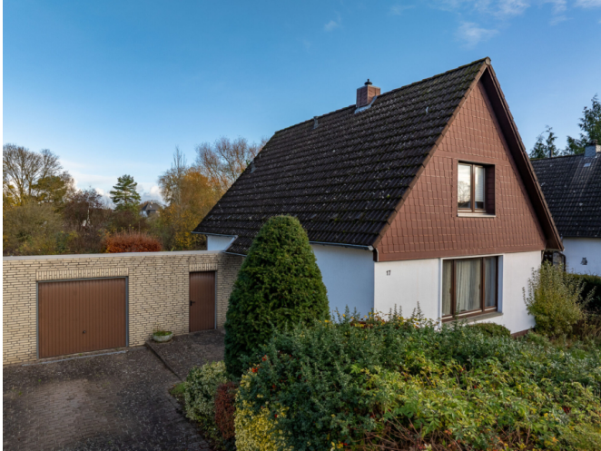
Ansicht Strasse mit Garage
