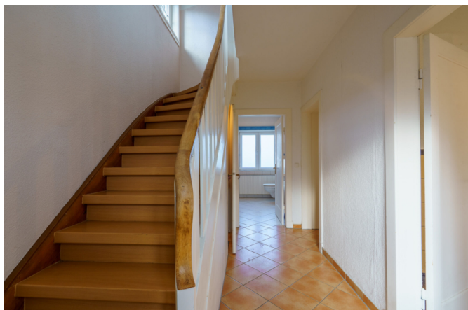
Treppe ins Obergeschoss
