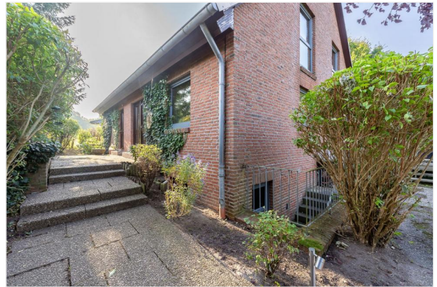
Blick zu den Haustüren
