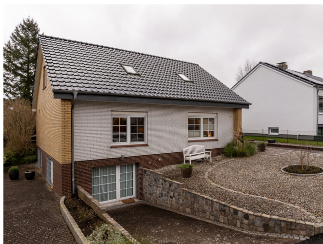
Strassenseite mit Zugang zur Kellerwohnung
