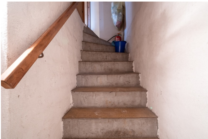
Treppe zum Kellergeschoss
