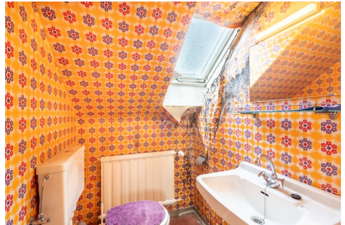
WC im Dachgeschoss
