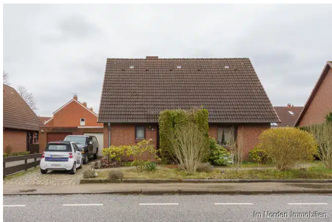
Hausansicht von der Straße
