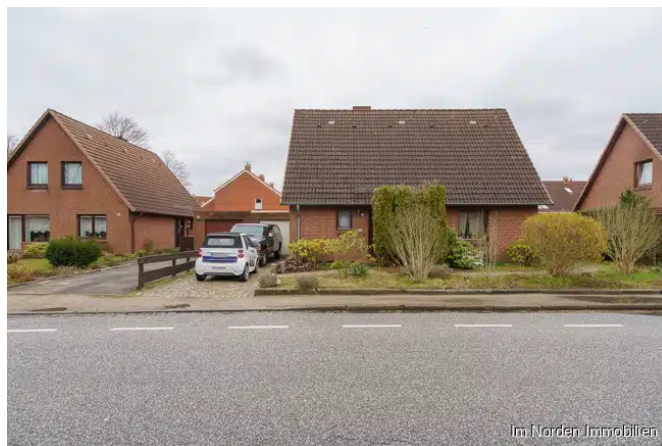
Hausansicht von der Straße
