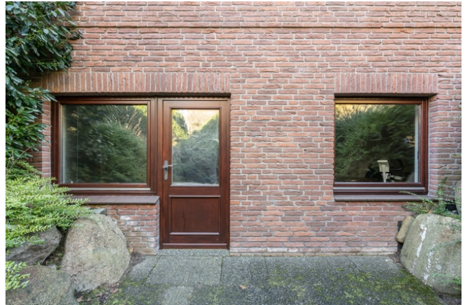
Blick auf den separaten Hauseingang im Kellergeschoss
