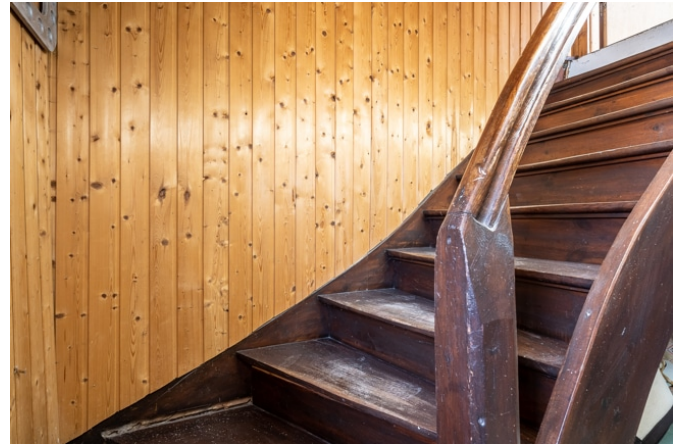
Treppe zum Kellergeschoss
