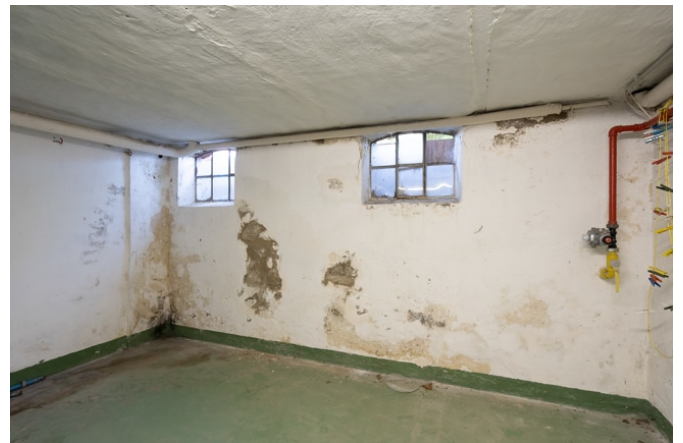
Kellerraum ca. 14 m 2
