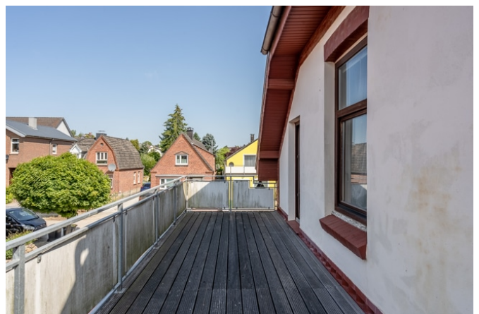
Loggia im Dachgeschoss
