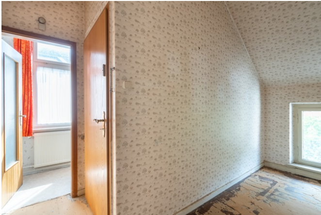
Flur im Dachgeschoss
