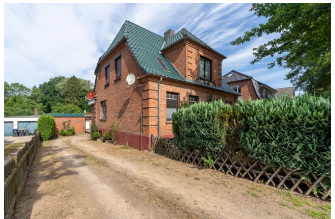
Zuwegung auf das Grundstück
