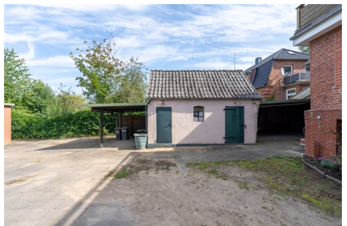
Blick auf das Nebengebäude
