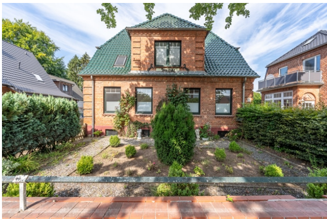
Hausansicht von der Ringstraße
