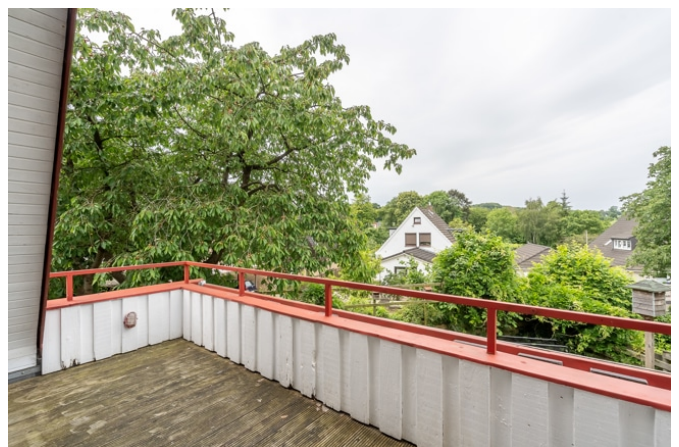
Loggia / Balkon im Dachgeschoss
