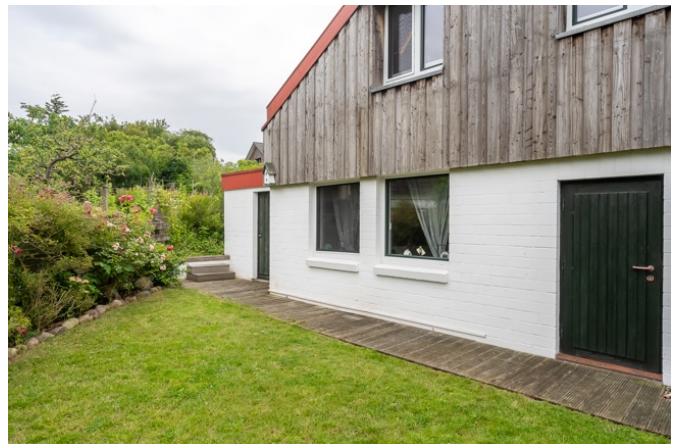
Blick zum Heizungsraum
