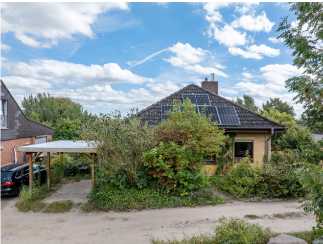
Blick von der Straße
