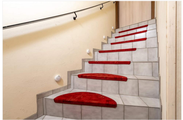
Treppe ins Kellergeschoss
