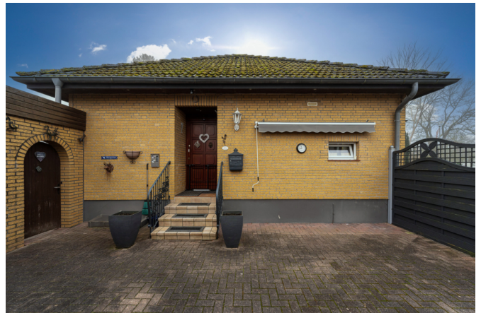
Blick auf den Hauseingang
