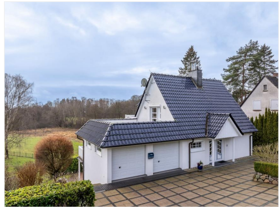
Ansicht von der Strasse
