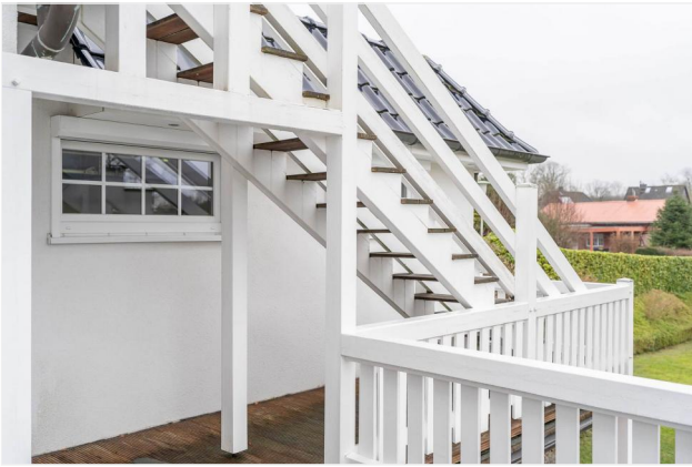
Zugang zur Dachterrasse
