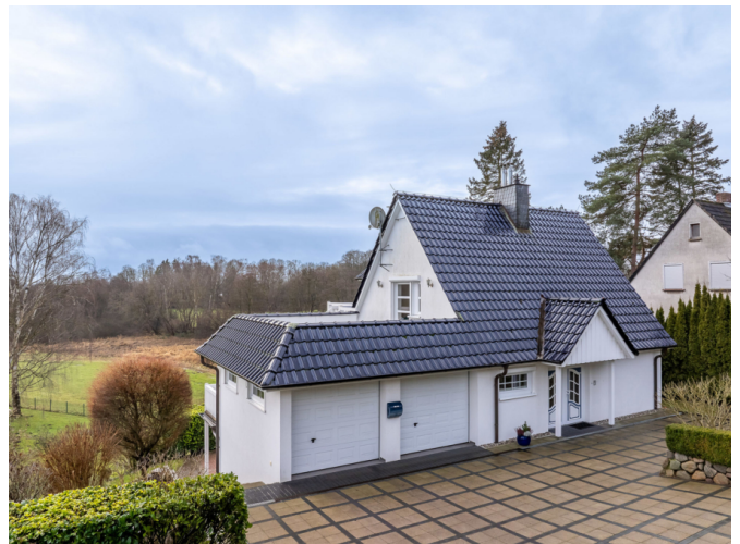
Ansicht von der Strasse
