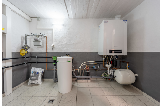
Gasheizung, Wasserenthärter
