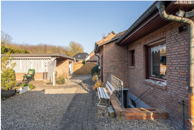
Hofplatz mit Kellerzugang
