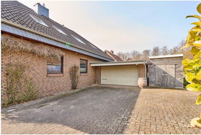
Hofplatz, Garage, Abstellschuppen
