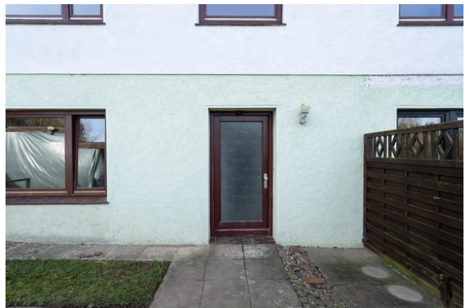
Hauseingang zum Kellergeschoss
