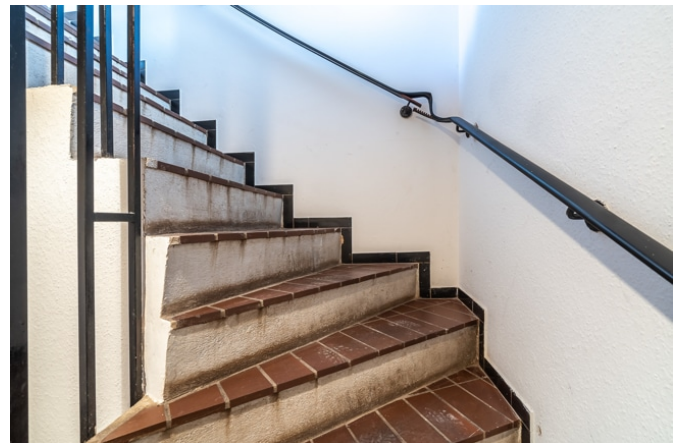
Treppe ins Kellergeschoss
