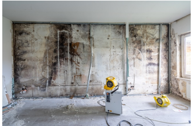
Wohnnebenraum ca. 16,5 m 2 im Kellergeschoss
