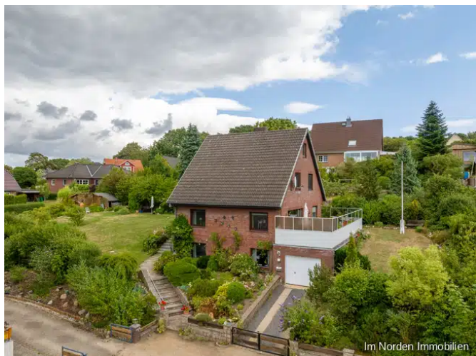
Blick auf das Haus mit Zufahrt
