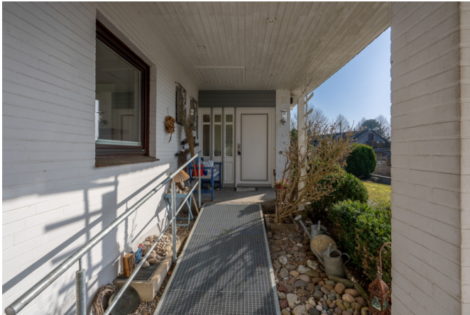
Rampe zum Eingang
