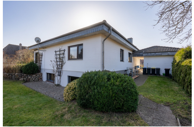
Hinterseite Haus, Durchgang nach vorne, Garage
