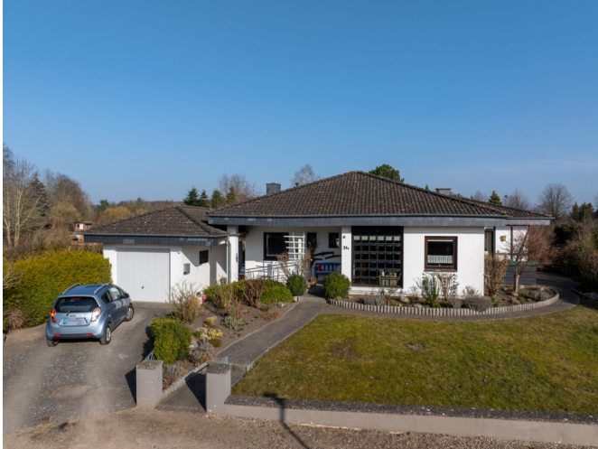
Ansicht von der Dorfstr., Auffahrt, Garage
