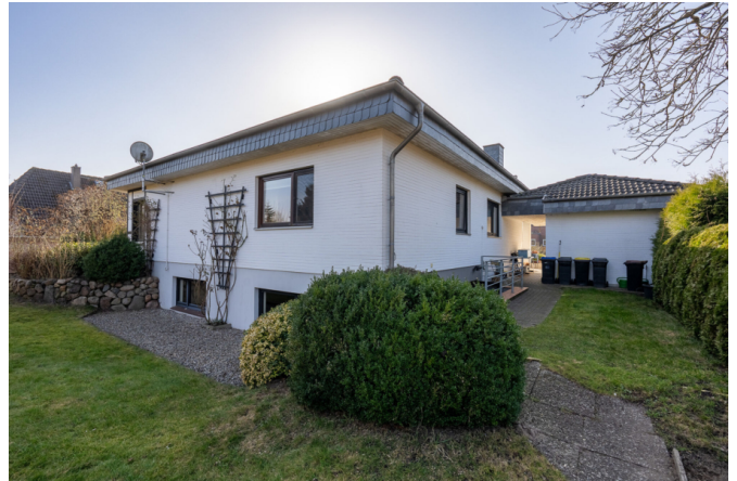
Hinterseite Haus, Durchgang nach vorne, Garage
