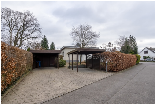
Hausansicht vom Schulweg
