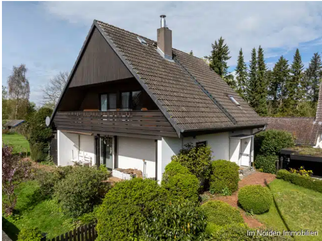
Giebelansicht von der Straße
